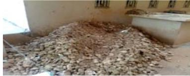
الصورة عدد 01 : دار الكتب الوطنية، شقوق بالحائط الخارجي لمبنى المخازن تسربت عبرها مياه الأمطار، أسفل فجوة ردمت بالتراب بعد الحادث
